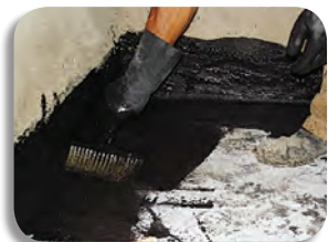
Aplicação da segunda camada de emulsão sobre o Bidim VP. Aplicación de la segunda capa de emulsión sobre Bidim VP.
