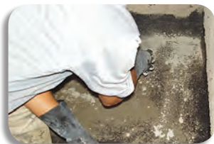
Salgamento da superfície com cimento. Salgamiento de la superficie con cemento.
